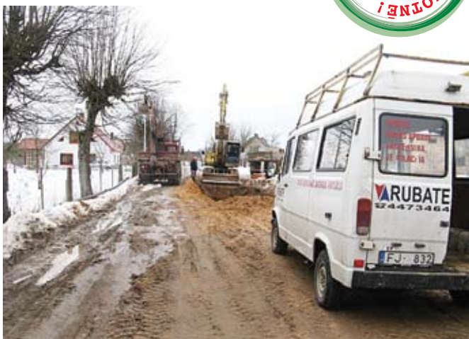
MONTĀŽA. Ūdensvada tīklu montāža Gulbenē, Stacijas ielā
