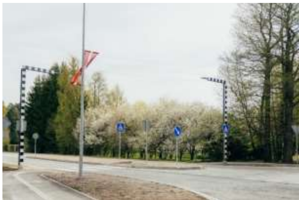
24. attēls. Projektā “Gājēju infrastruktūra Tallinas ielā” Melnsila ielas un Limbažu ielas krustojumā izbūvēta gājēju ietve un gājēju pāreja drošai Tallinas ielas šķērsošanai
