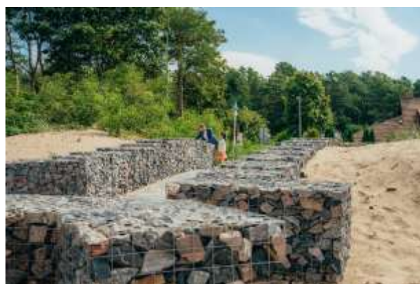
23. attēls. Projektā “Infrastrukturā izbūve pludmalē pie stāvlaukuma Raiņa ielā” izbūvēta gabionu siena kāpu aizsardzībai
