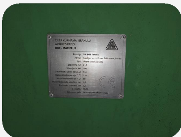
11. attēls. Katla telpa un cietā kurināma katls BIO - MAX PLUS
