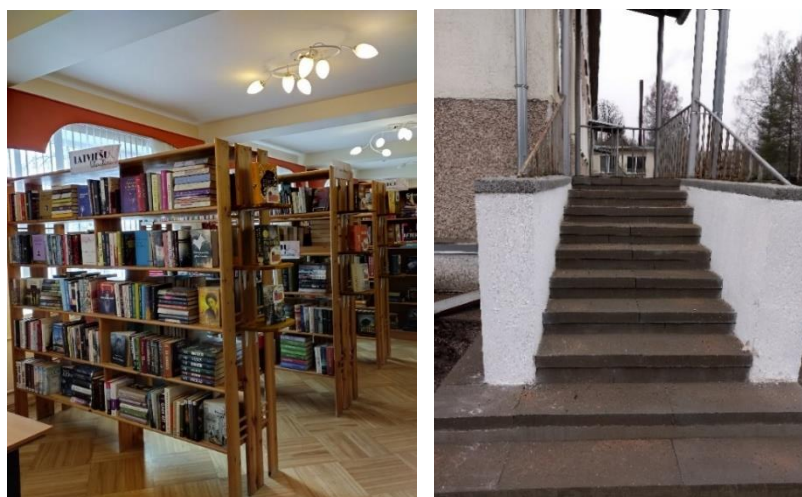
60. attēls. Kāpnes uz bibliotēku Strautiņos pēc remonta
