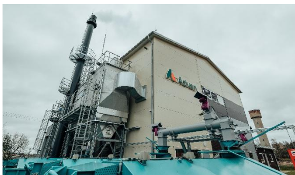
5. foto. Katlu māja Rietekļa ielā 1.
