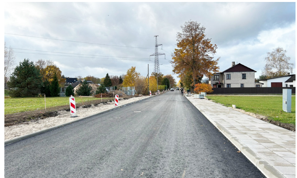
Pārbūvēta Pededzes iela posmā no Daugavas ielas līdz Rožleju ielai Mārupē.
