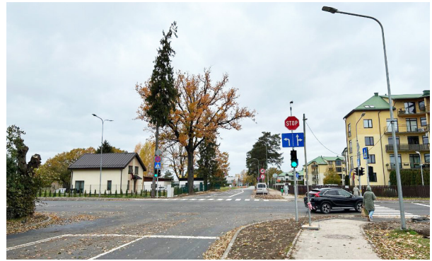
Veikta Lielās un Kantora ielas krustojuma pārbūve Mārupē, izbūvējot luksoforu.
