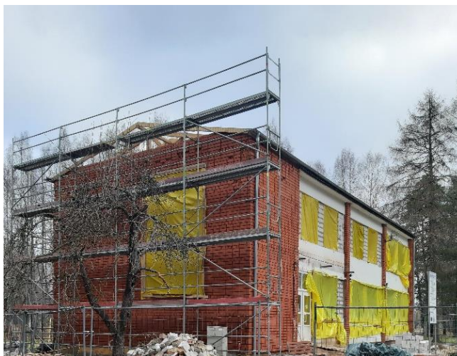
1.13. attēls. Ēka “Bērzi” būvdarbu laikā
