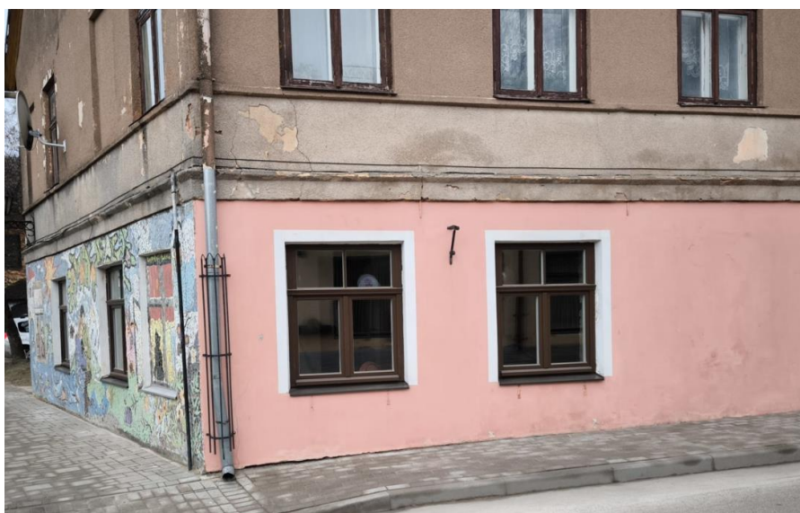
3.31.attēls. Nomainītie logi Lielā ielā 25-4, Kandavā (1.stāvs)
