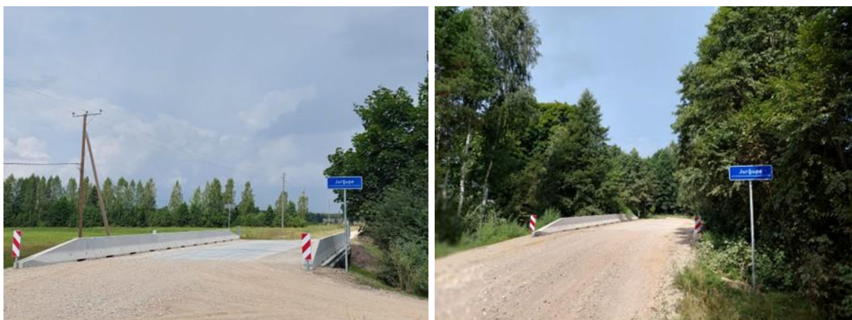
1.23. un 1.24. attēls. Tilti pār Jurgūpi (5,7. km un 2,94. km) Zentenes pagastā
