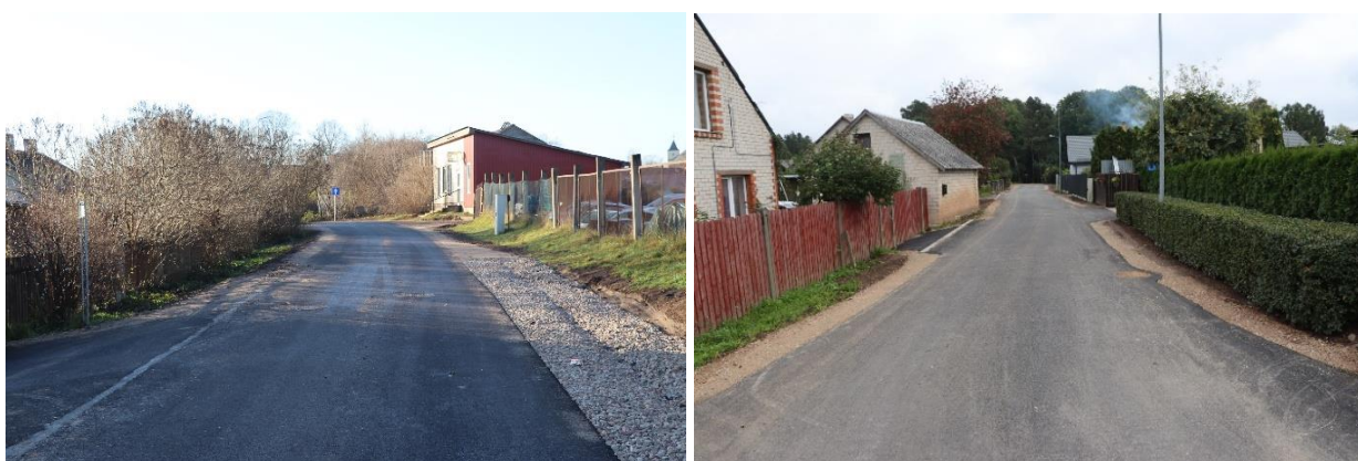
1.18. un 1.19. attēls. Ziedoņa iela un Pīlādžu iela pēc pārbūves
