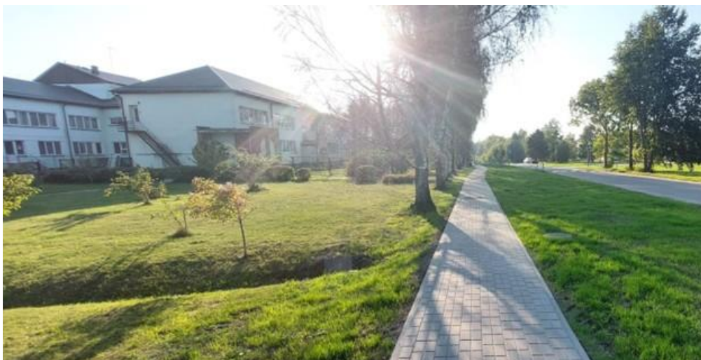
1.27. attēls. Izbūvētā gājēju ietve Skolas ielā Zantē
