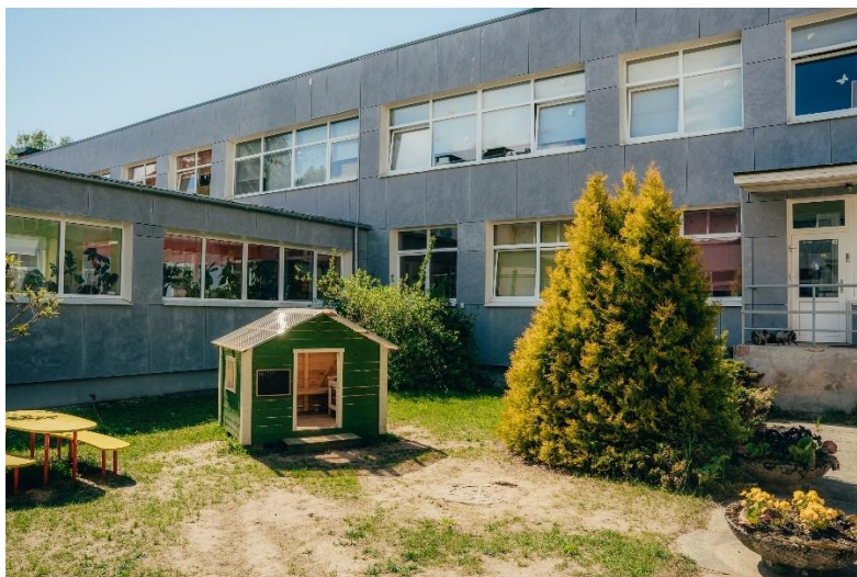
10.attēls. Pērn Saulkrastu PII “Rūķītis” tika nosiltinātas ārsienas.
