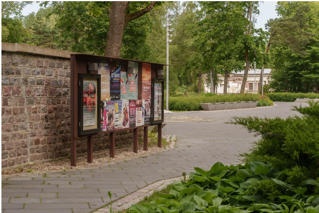
9.Labiekārtojumā saglabāta mūra siena no iepriekšējā teritorijas labiekārtojuma.
