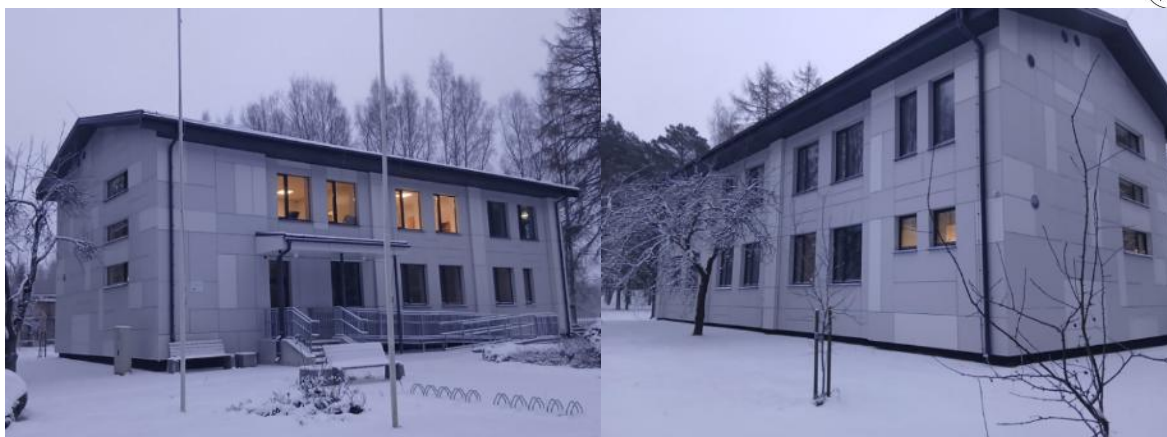
1.26. un 1.27. attēls. Ēka “Bērzi” pēc energoefektivitātes paaugstināšanas pasākumu īstenošanas
