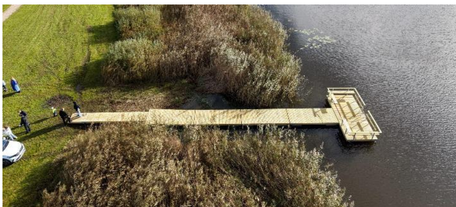
2.2. attēls. Pie Slampes dīķa izveidota pontona laipa, kas kalpos gan kā ainavisks elements, gan kā funkcionāla piekļuves vieta dīķim
