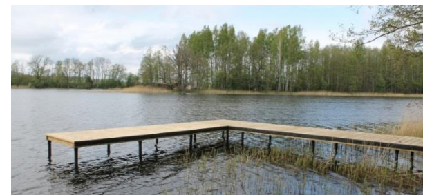
Foto. Ulbrokas ezera laipa – estakāde uz pāļiem 26
