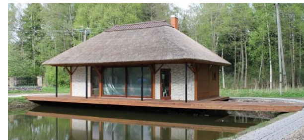
Foto. Pirts ēka uz skrūvpāļiem virs dīķa, Zvejniekiems, Saulkrastu novads 25
