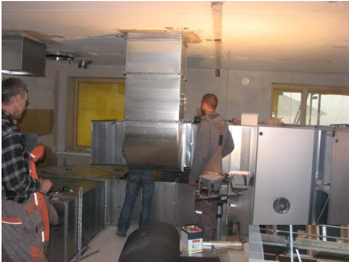
Ventilācijas izbūve 5.stāvā
