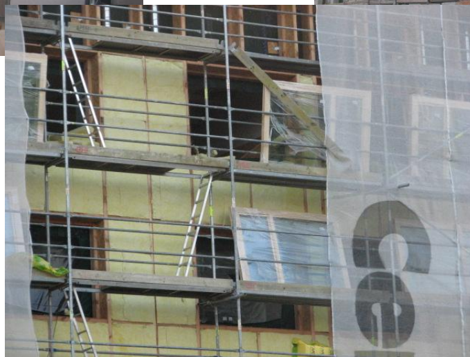
Logu likšana, siltināšana ar minerālvati
