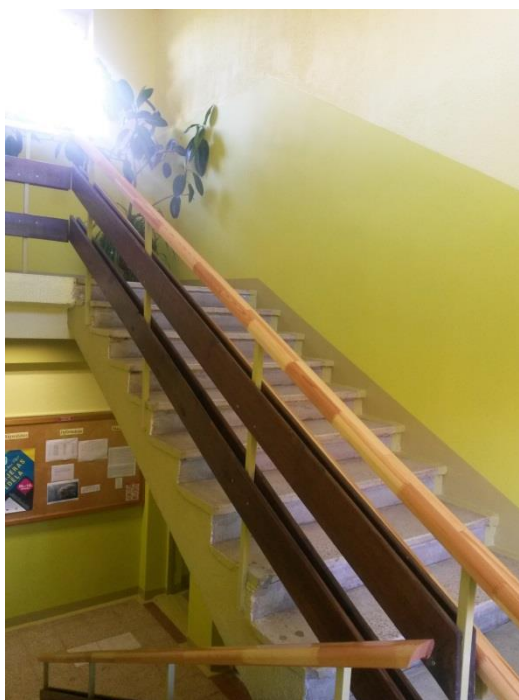
24. attēls. Ilzenes pamatskolas ēkā veikts koridora remonts
