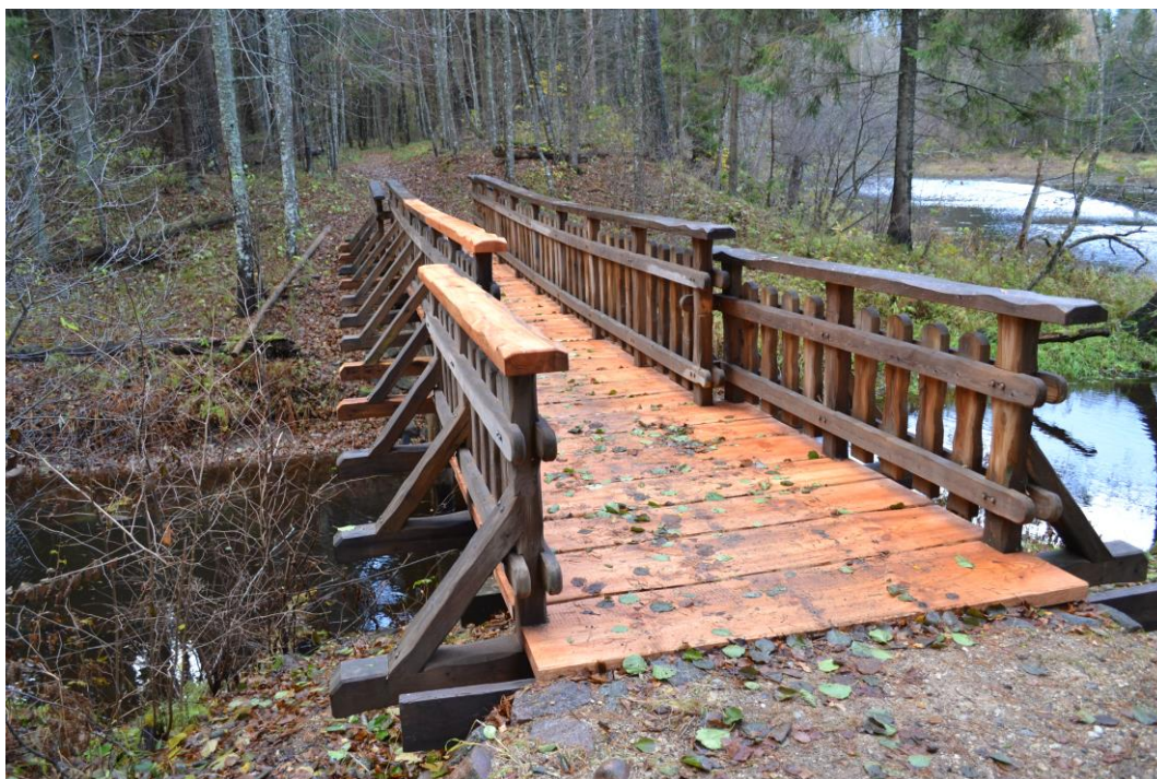
9.att. Gājēju tilts pār Gaujas ateku / Foto I.Ence
