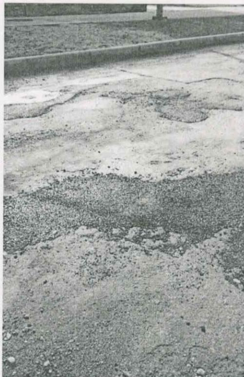
Laika periodā, kad vidējā gaisa temperatūra nepārsniedz  $+15^{\circ}$ , asfaltā izveidojušās bedrītes tiek aizpildītas ar aukstā asfalta masu.
