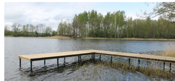
Foto. Ulbrokas ezera laipa – estakāde uz pāļiem 26
